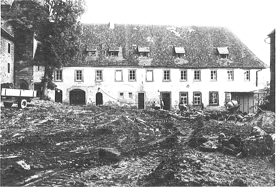
Dorferneuerung Münchsteinach: Platz und Gebäude bei ehemaliger Klosterkirche vor Renovierung
