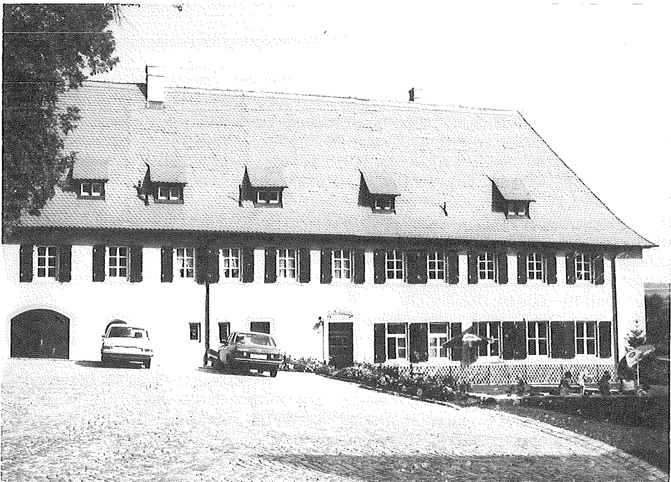
Dorferneuerung Münchsteinach: Platz und Gebäude nach Renovierung
