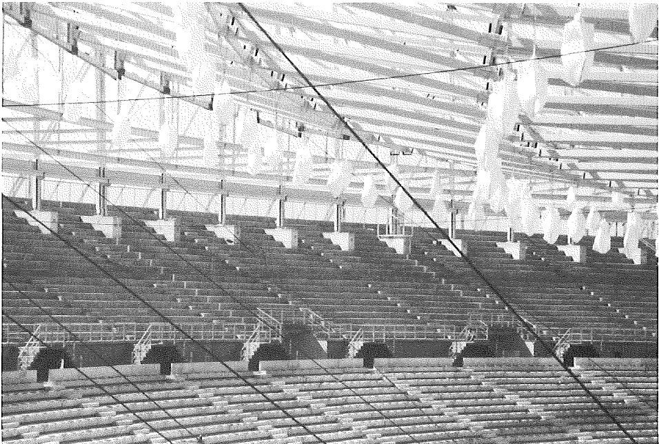
Abb. 2: Die Dachkonstruktion von unten
