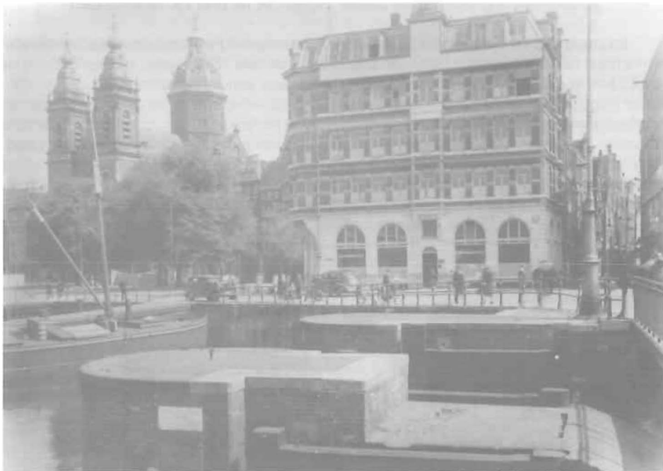
Abb. 1: Letzter Original-„dykpeilsteen“ in der „Nieuwe Burg“-Schleuse
