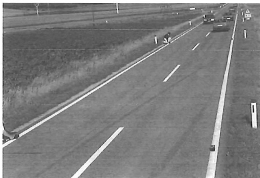
Abb. 2: Aufnahme des ersten Teilstückes
