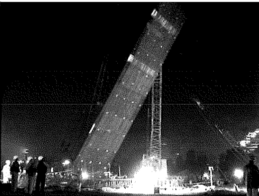
Abb. 4: Einsetzen des Bewehrungskorbes in ein Schlitzwandpanel
