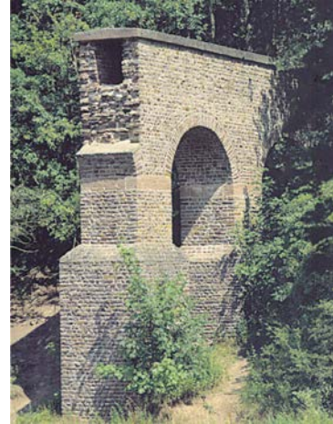
Abb. 10: Eifelwasserleitung nach Köln, Aquäduktbrücke bei Mechernich-Vussemer.
