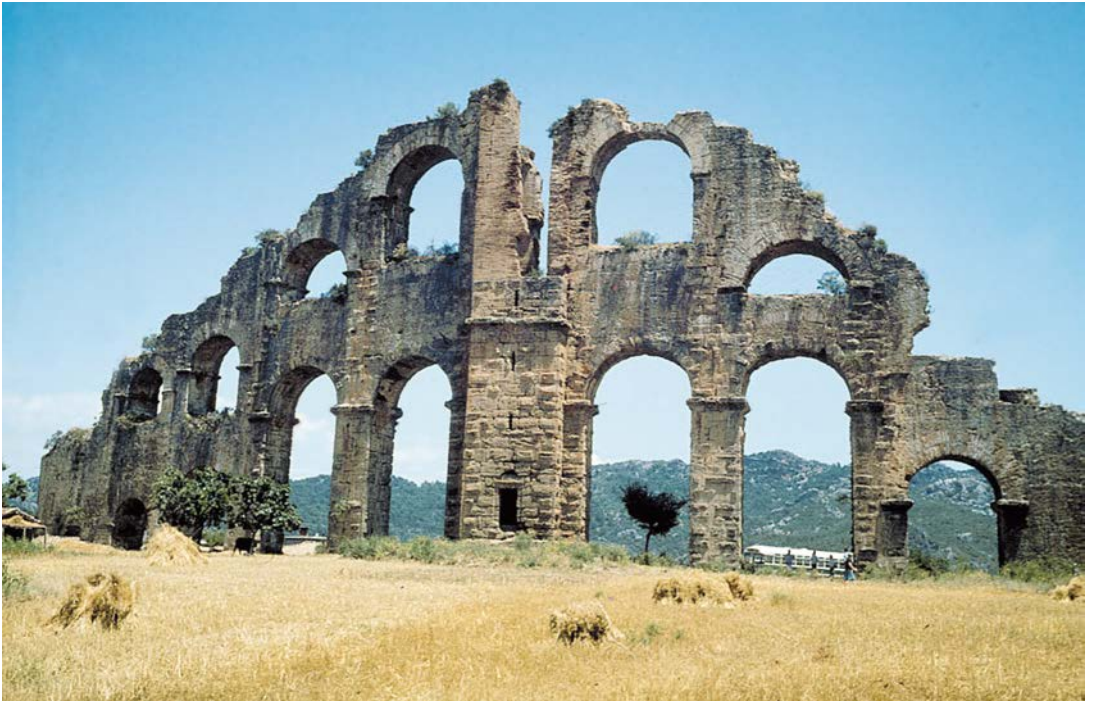
Abb. 16: Aspendos (Türkei), 40 m hoher Turm zur Druckentlastung einer Druckleitung.
