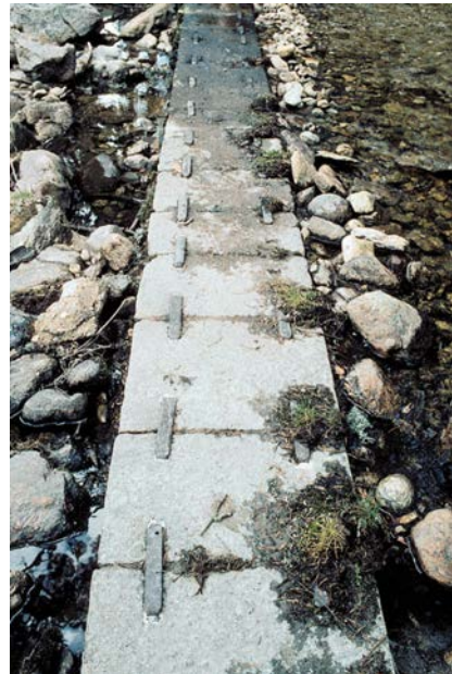
Abb. 6: Segovia (Spanien), die Steinquader des Wehres werden mit verbleiten Eisenklammern zusammengehalten.
