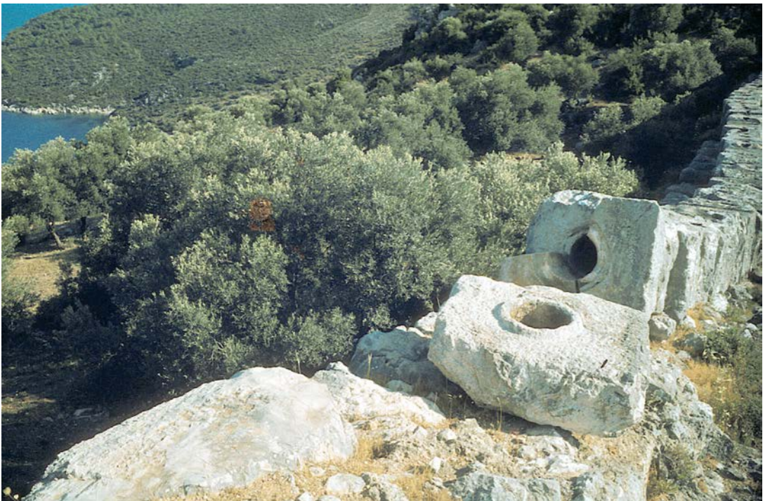
Abb. 17: Patara (Türkei), Steineröhre einer Druckleitung.
