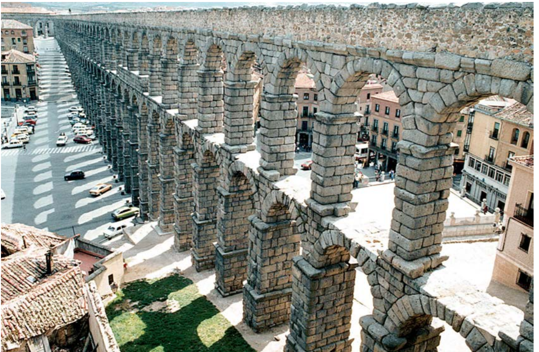
Abb. 11: Segovia (Spanien), Aquäduktbrücke.
