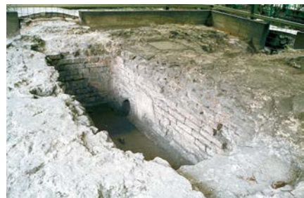
Abb. 21: Eifelwasserleitung nach Köln, Absetzbecken zur Klärung des Wassers vor der Stadt im Kölner Grüngürtel.
