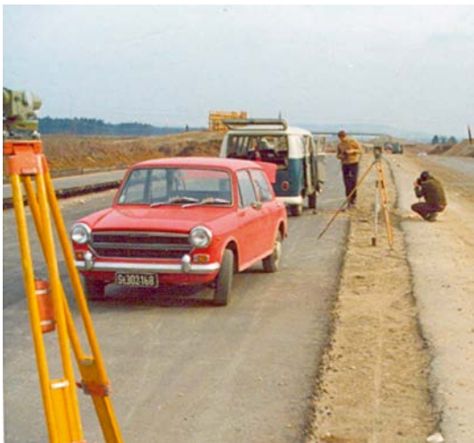
Abb. 8: Feinabsteckung der Autobahnachse Graz Knoten West – Weitendorf (Pyhrnautobahn)
