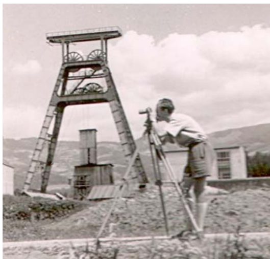
Abb. 1: Obertägige Vermessung unterm Förderturm, Kohlebergbau St. Stefan i. L.
