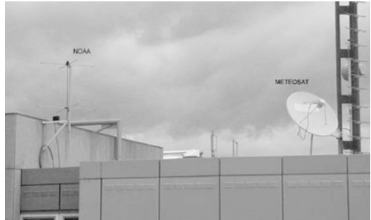
Abb. 12: Demonstrationseinrichtung zur Satelliten-Fernerkundung: links omnidirektionale Dipol-Antenne für NOAA (polständige Umlaufbahn), rechts Parabolantenne für METEOSAT (geostationär)
