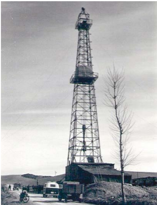
Abb. 3: Bohrturm in Nordspanien
