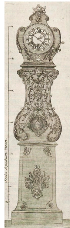
Abb. 87.1: Pariser Äquationsuhr von Le Faucheur Alexandre, bei der die Stellung einer zusätzlichen Skala durch eine Kurvenscheibe gesteuert wurde, um so auch die wahre Sonnenzeit anzuzeigen („mechanische Sonnenuhr“); auf dem Zifferblatt oberhalb von XII ist angegeben: „Temporis Aequalitas“; angezeigte Uhrzeit (mittlere Sonnenzeit): 2 Uhr 53' 29". Abb. 87.2: die kunstvoll gestaltete Äquationsuhr in ganzer Größe; beide Abb. aus: „De astronomica specula domestica“, Lib.II, S. 186 und S. 191 [beider Quelle: ETH-Bibliothek Zürich, Sign.: Rar 8917 q]
