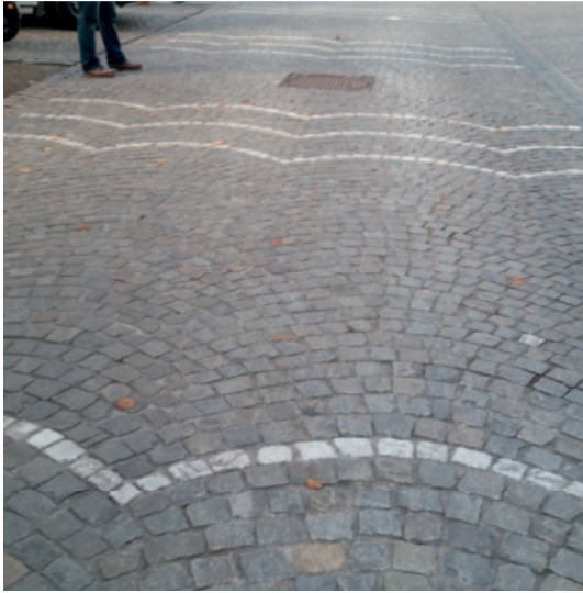
Abb.4: Ein Beispiel für Kopfsteinpflaster mit den Attributen „surface=sett; sett:pattern=arc“ (Quelle: https://goo.gl/zy2dLb ).
