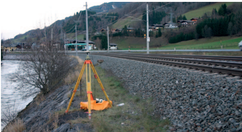
Abb. 2: Schaffung von GPS-Netzen entlang der Bahn
