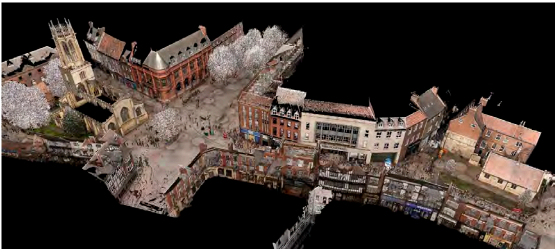
Eingefärbte Punktwolke des Stadtzentrums von York, UK; 149 Scanpositionen in 2 Stunden und 11 Minuten; Aufnahmen vom 15. März 2023
