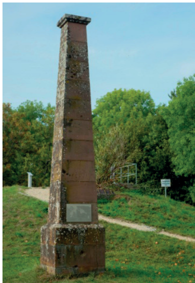
Abb. 2: Gradmessungspfeiler Dreifaltigkeitsberg, einer der 35 Hauptpunkte des Rheinischen Dreiecksnetzes, Europäische Gradmessung 1875, Foto: Dietrich Krieger
