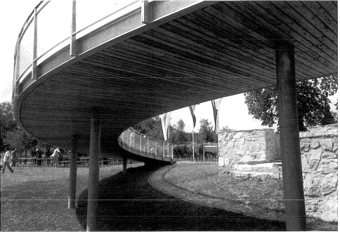
Abb. 2: Der elliptische Steg von Mitterretzbach
