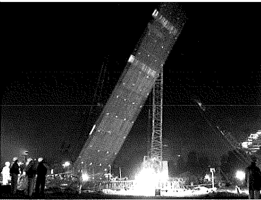
Abb. 4: Einsetzen des Bewehrungskorbes in ein Schlitzwandpanel
