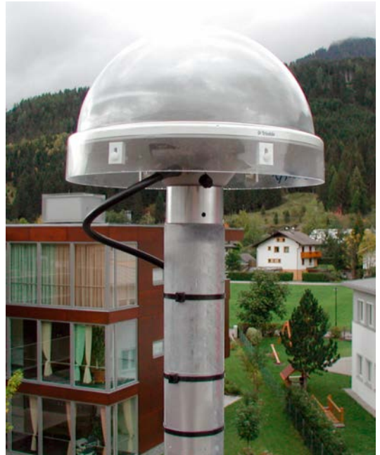
Abb. 4: GPS-Antenne mit Radom (Station Sillian)
