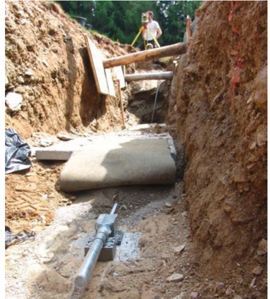
Abb. 10: Faseroptischer Sensor beim Einbau
