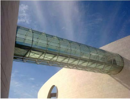
Abb. 3: Die Glasbrücke zur Verbindung von zwei Gebäudeteilen im Champalimaud Centre for the Unknown, Lissabon (Architekt: Charles Correa, Tragwerksplanung: Schlaich Bergermann und Partner)
