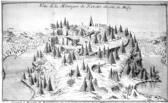
Abb. 5: Maupertuis, Bau eines Signals bei Niemi
